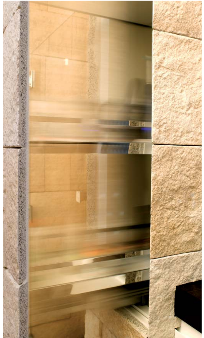
Im Bad zeigt sich das ganze handwerkliche Können des Teams: Die seitlich in die Trennwand eingelassenen Regale sausen auf ein Anklopfen heraus, die Armaturen symbolisieren mit blauem und rotem Licht die gewählte Wassertemperatur
